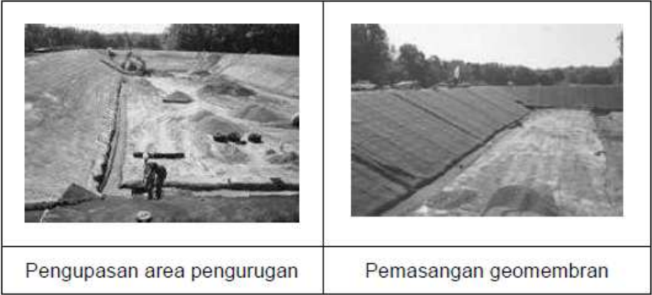
Gambar 14 - Konstruksi Sistem Pelapis Dasar ( Liner )
